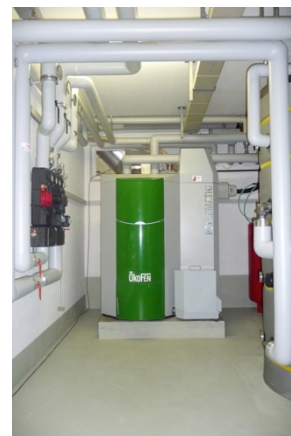
Vollautomatische Pelletsanlage ÖkoFEN PELLEMATIC PES 56 mit 56kW Leistung. Ausgerüstet mit Vakuumsaugsystem, Brenner & Steuerung inkl. Bedienteil mit Touchscreen.
