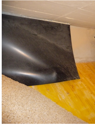
Pelletslager mit 43m 3 im umgenutzten Öltankraum. Die Grundfläche beträgt 7.2 x 4.1m. Bei einer Raumhöhe vom 2.2m liegt die Befüllmenge bei 28t Pellets. Der Jahresbedarf beträgt ca. 22t.
