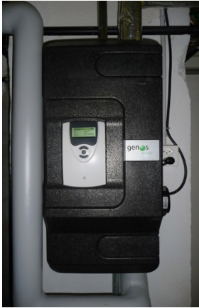
Frischwassermodul zur hygienischen Wasseraufbereitung.
