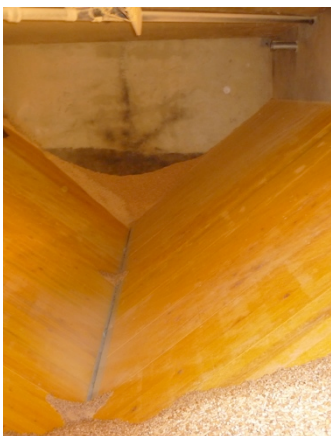
Pelletslager mit 43m 3 im umgenutzten Öltankraum. Die Grundfläche beträgt 7.2 x 4.1m. Bei einer Raumhöhe vom 2.2m liegt die Befüllmenge bei 28t Pellets. Der Jahresbedarf beträgt ca. 22t.
