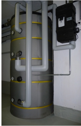
Frischwassermodul zur hygienischen Wasseraufbereitung.
